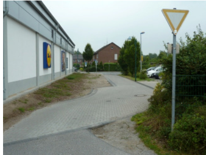
Foto 1: Blickrichtung: Postweg - Bahnhofstraße Rechts: Ausfahrt vom „Netto-Parkplatz“ Mitte unten: Schlagloch
